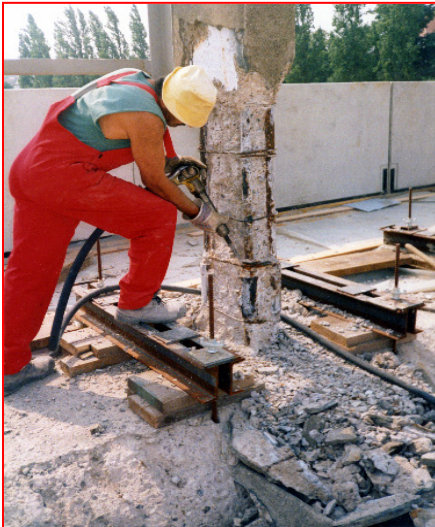
Abtrag loser Teile der Altmörtelschale und des Konstruktionsbetons mittels Stemmen mit leichtem Handgerät und nachträglichem Strahlen mit festen Strahlgut
