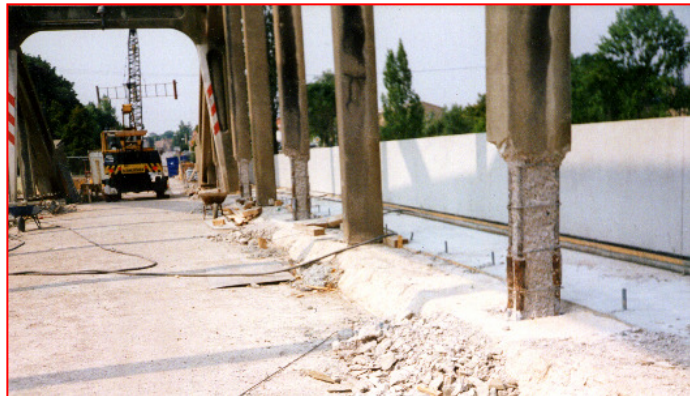
Abtrag loser Teile der Altmörtelschale und des Konstruktionsbetons mittels Stemmen mit leichtem Handgerät und nachträglichem Strahlen mit festen Strahlgut
