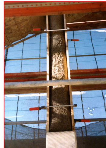
Stellung einer fluchtgerechten Schalung zur Wiederherstellung aller Bauwerkskanten
