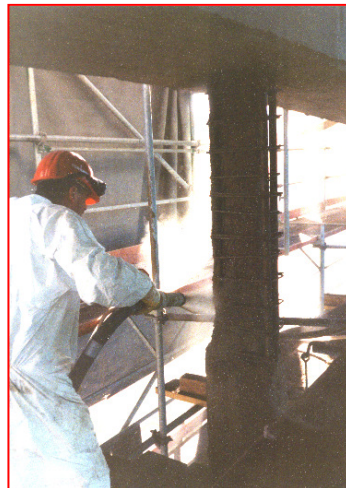
Auftrag eines kunststoff-modifizierten Spritzmörtels (SPCC) mit Edelstahlfasern im Trockenspritzverfahren
